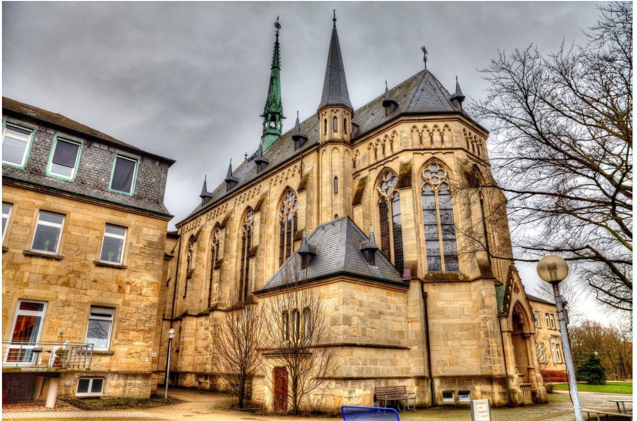
Der 1897 begonnene Bau der Kapelle „Maria Hilf“ wird 1899 fertiggestellt
